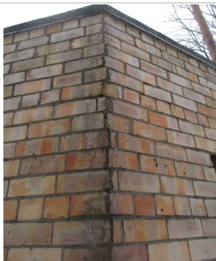
Platleņķa stūra mūrējuma šuve nav aizsargāta no nokrišņu iedarbes
