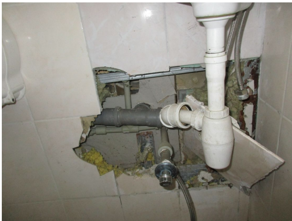
Apdares un ģipškartona loksnes bojājums telpu grupā I
