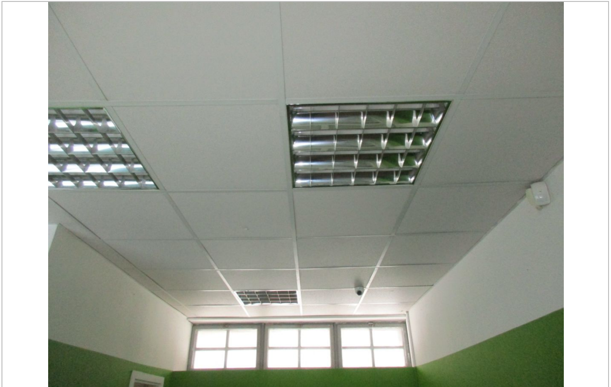
Griestu pārseguma plaknes bez ieliekuma, iekārto griestu stiprinājums noturīgs
